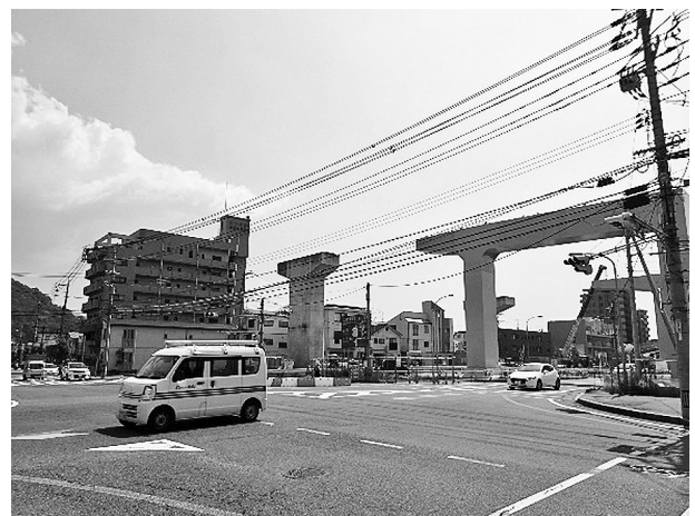
図-2 架空線状況
