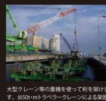
大型クレーン等の重機を使って桁を架けます。(650t・mトラバークレーンによる架設)
