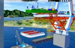
⑦エレクションガーダーによる主桁吊上げ架設
