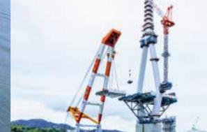
⑥起重機船による主桁架設
