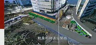
2 軌条桁縦送り
