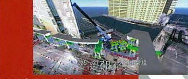
1ブロック架設
