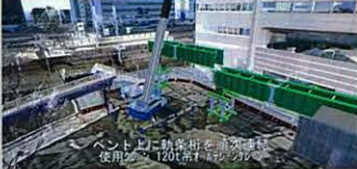
1 ベント上に軌条桁を連結
