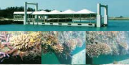
サンゴ棚を設置するところ
