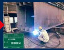
組み立てた厚板を溶接でつなぎ合わせて桁が完成します。
