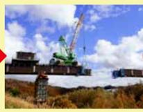
大型クレーン等の重機を使って桁を架けます。(650t・mトラベラクレーンによる架設)
