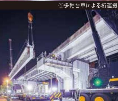
②PC桁の大型クレーンによる相吊架設
